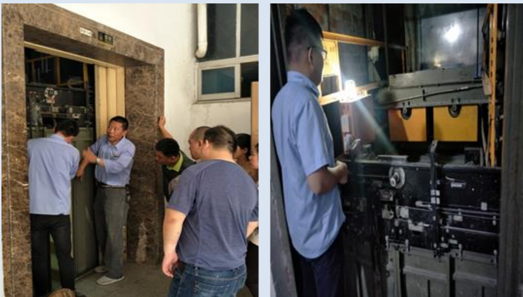
图 20：学生在进行电梯安全救助演练和学生进入轿顶检查维修
