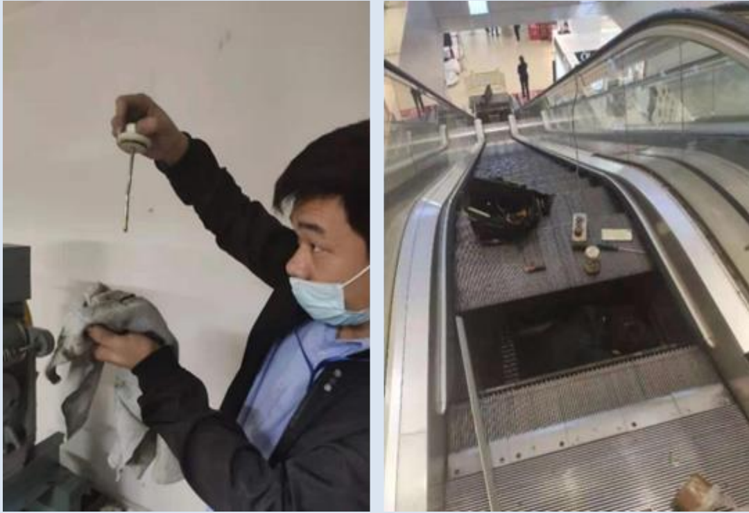
图 17：学生在保养电梯检查变速箱油位和抢修商场扶梯现场
